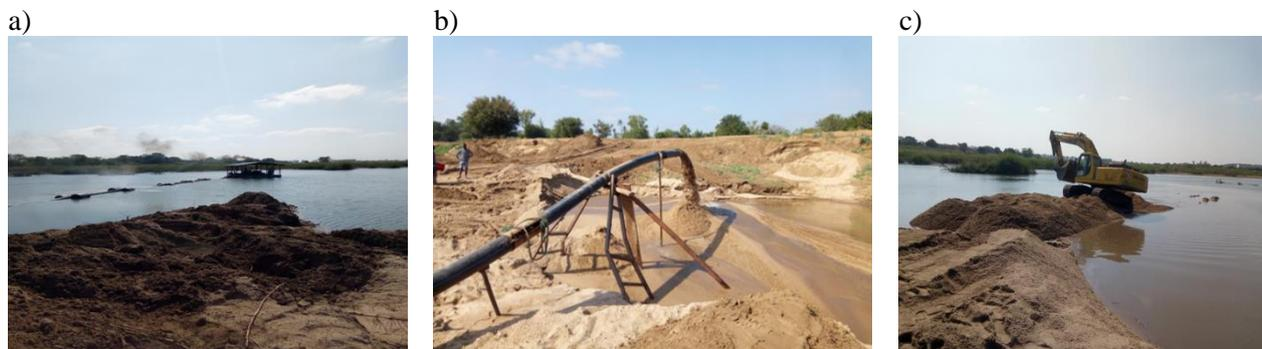
Figura 3. Métodos de extracção de areia grossa dragagem a) e b); e retroescavadora c). Fonte: Autores (08/2022).
